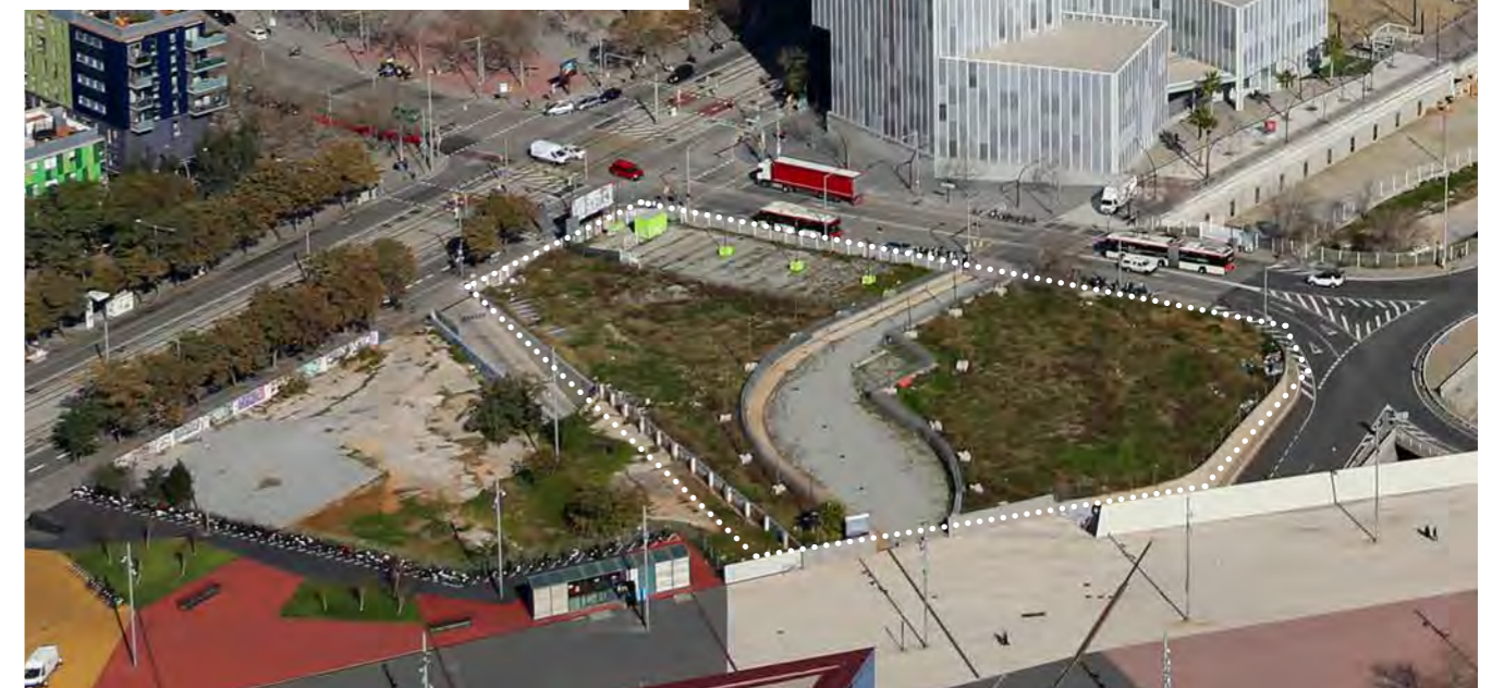
Vista aèria de les parcel·les L/M del Campus Diagonal-Besòs amb el contorn ressaltat
