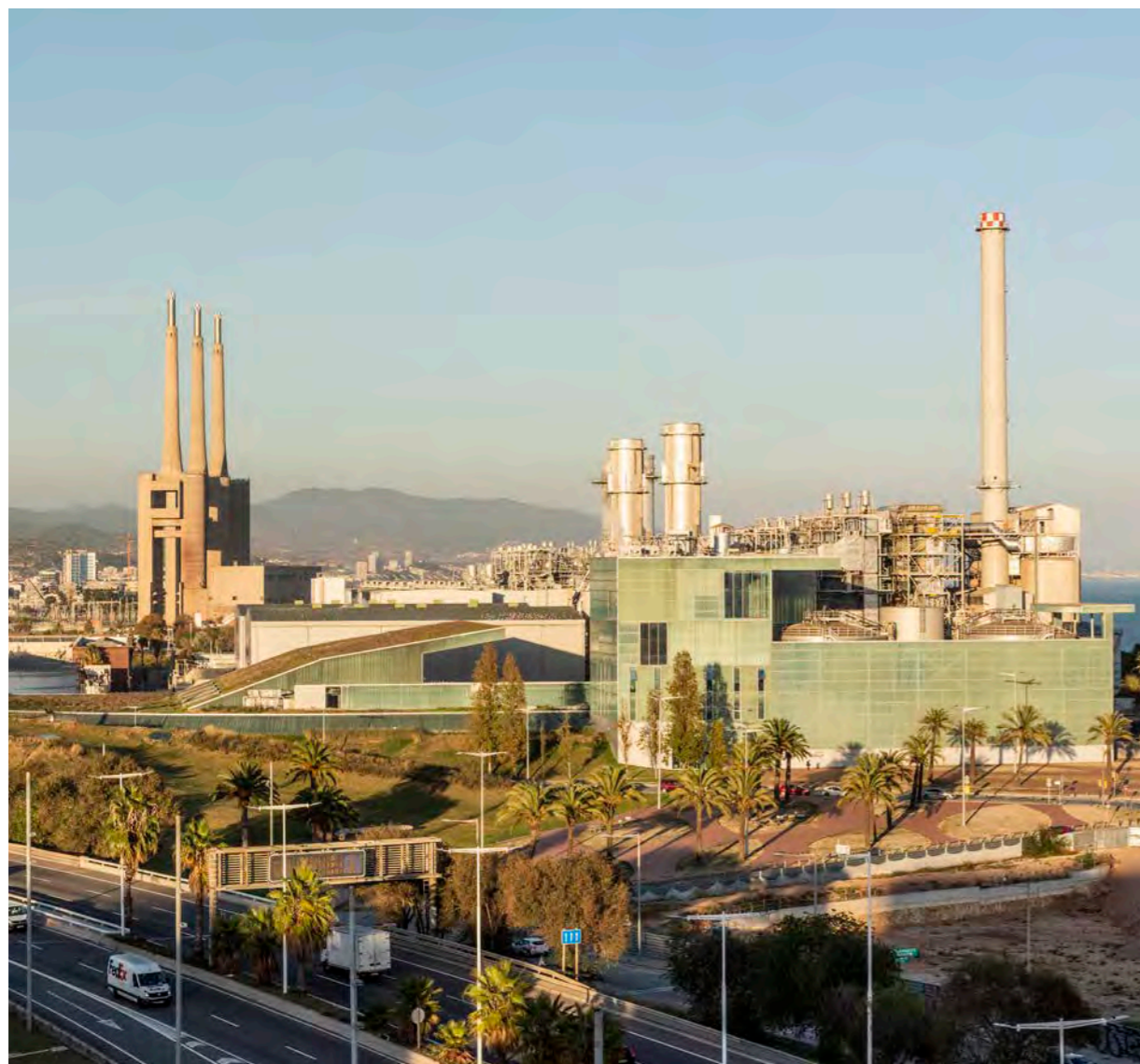
Instal·lacions de la central de cycle combinat que forma part de l'ecosistema del Campus Diagonal-Besòs
